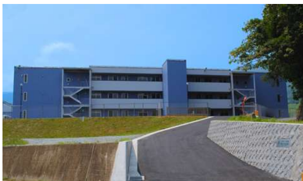
ホーリィヴィレッジ棟（3階建て） （バリアフリー対応済みです）
